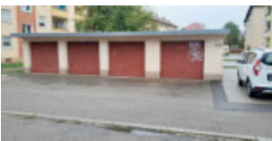
Garagenhöfe: Gotter-Nes-Weg/ Josef-Kohler-Straße
